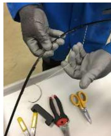
3. Le Mid-span est d'environ 160 cm de long, il doit être centrer autour de l'inversion SZ.
