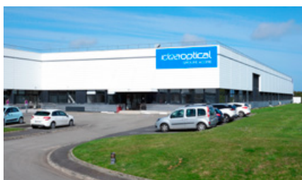
Nouvelle usine IDEA OPTICAL spécialisée dans la conception et l'intégration d'équipements de brassage et de raccordement optique à Lannion depuis août 2019. 2 armoires optiques sur 3 installées en France ont été conçues et fabriquées par Idea Optical.
