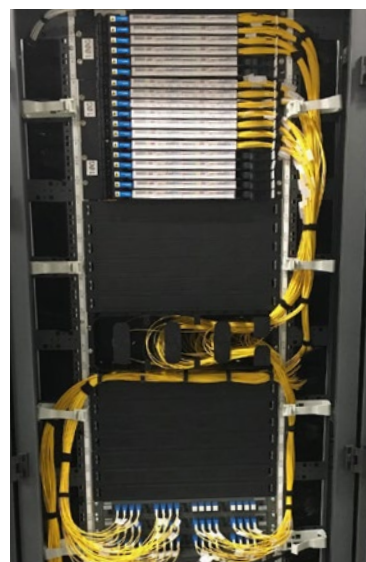
Résorbeur horizontal 3U intégré en baie 19"
