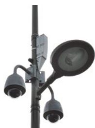
Fixation sur candélabre
