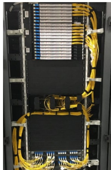
Résorbeur horizontal 3U intégré en baie 19"
