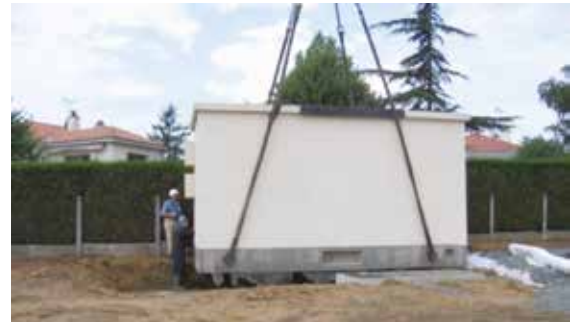
Opération de grutage
