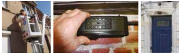
Points de branchement optique façade
