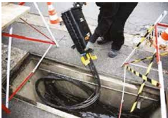
Mise en œuvre d'un boîtier d'épissurage en chambre
