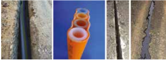
Assemblage de micro-tubes en nappe et pose en rainure
