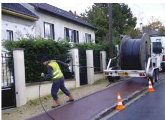
Mise en œuvre d'un câble 720 fibres par tirage (Bures sur Yvette – décembre 2012)
