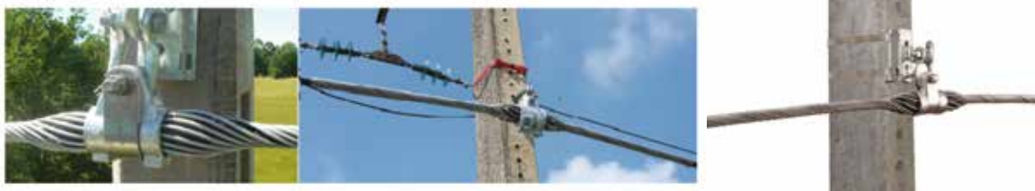
Exemple de suspensions spiralées renforcées
