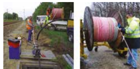
Pose de micro-tubes dans conduite PeHD
