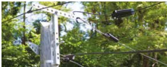
Installation d'une rehausse
