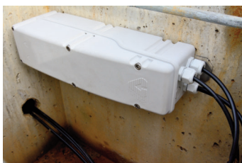
Installation im Kabelschacht
