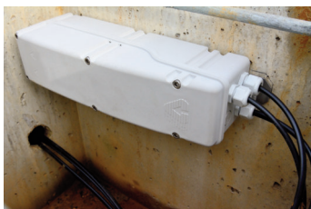
Installation im Kabelschacht
